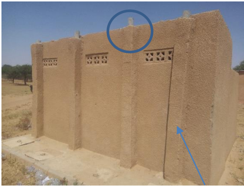
PVC manque d'Aplomb/ Manque de té
