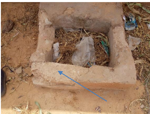
Brique en terre et pas de couvercle
