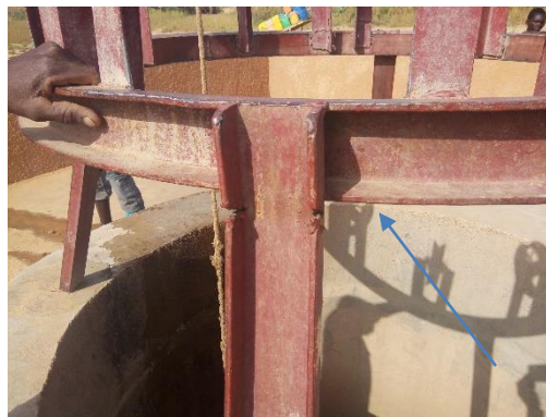
Soudure mal faite
