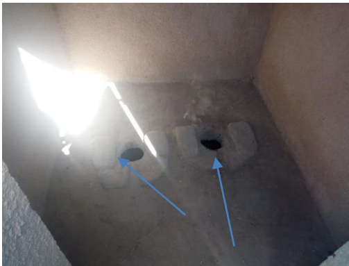
Deux trous ouverts au lieu d'un
