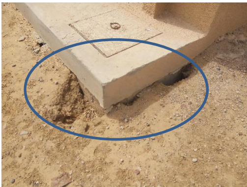
Enfouissements des eaux de pluies
