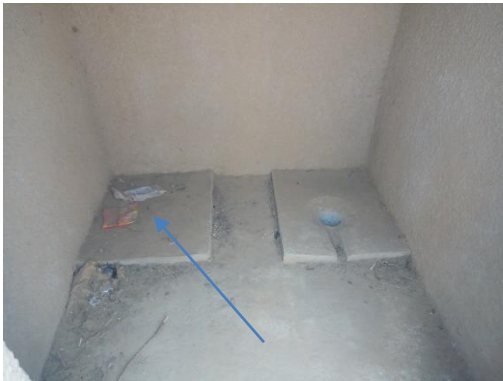
Pose pieds et trou bouché conformes
