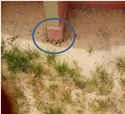
Enfouissement au pied de poteau
