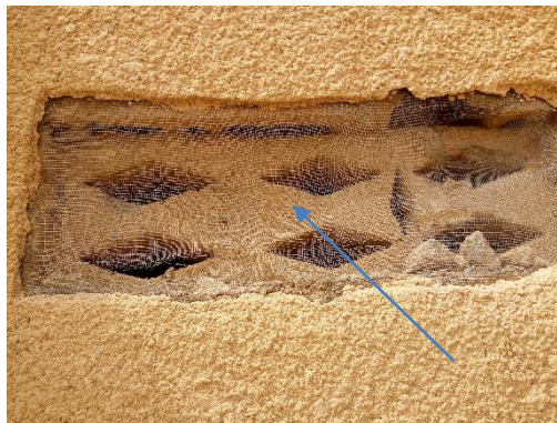
Grille anti vermine de mauvaise qualité
