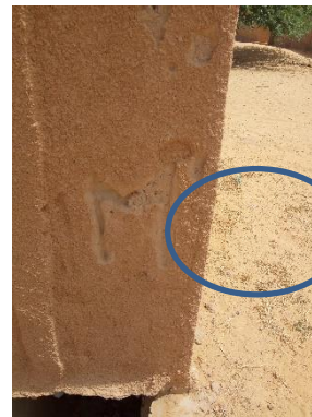
Manque de dalle de couverture du regard
