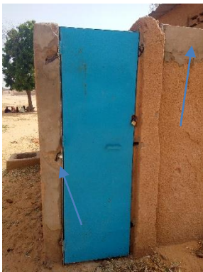
Rehaussement du mur
