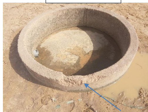
Soudure mal faite
