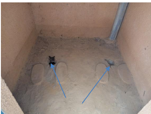
Deux trous ouverts au lieu d'un
