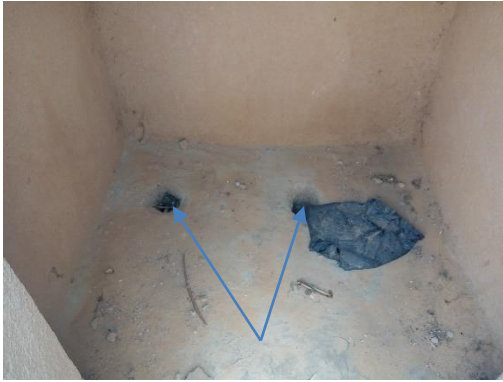
Deux trous ouverts au lieu d'un
